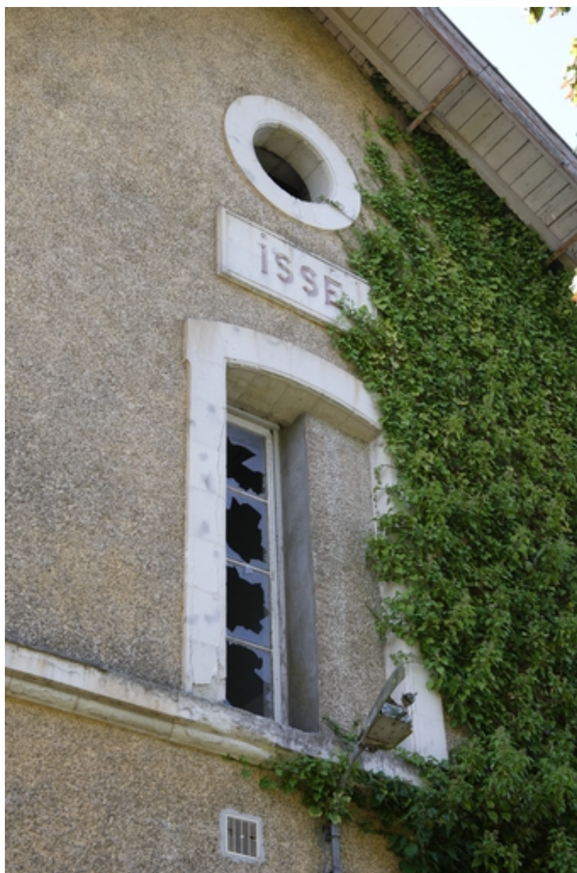
Détail façade côté Nantes.
