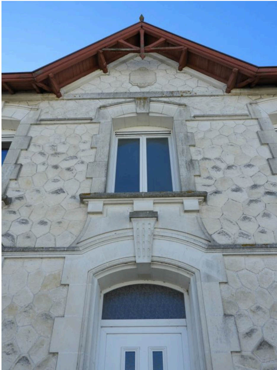
Détail de la façade : la travée centrale et son décor.
