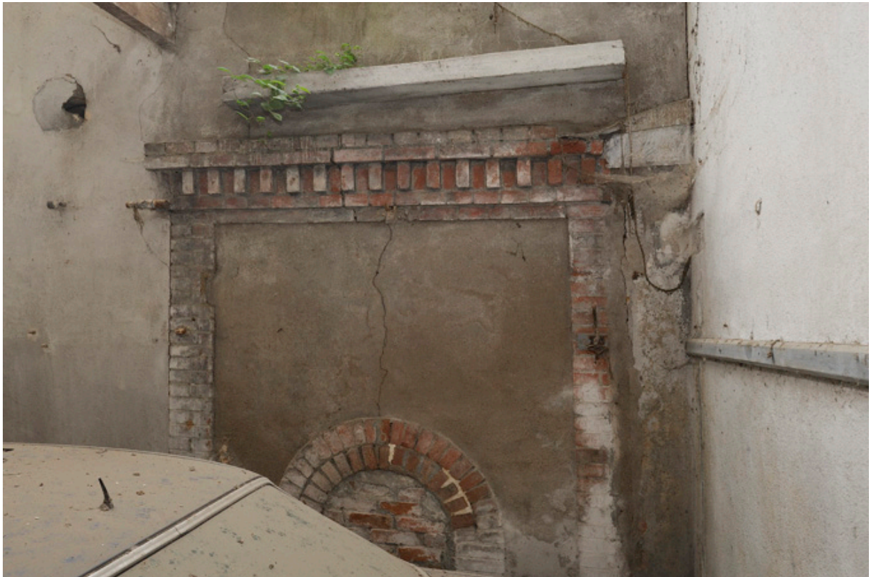
Four de la chaudière.
