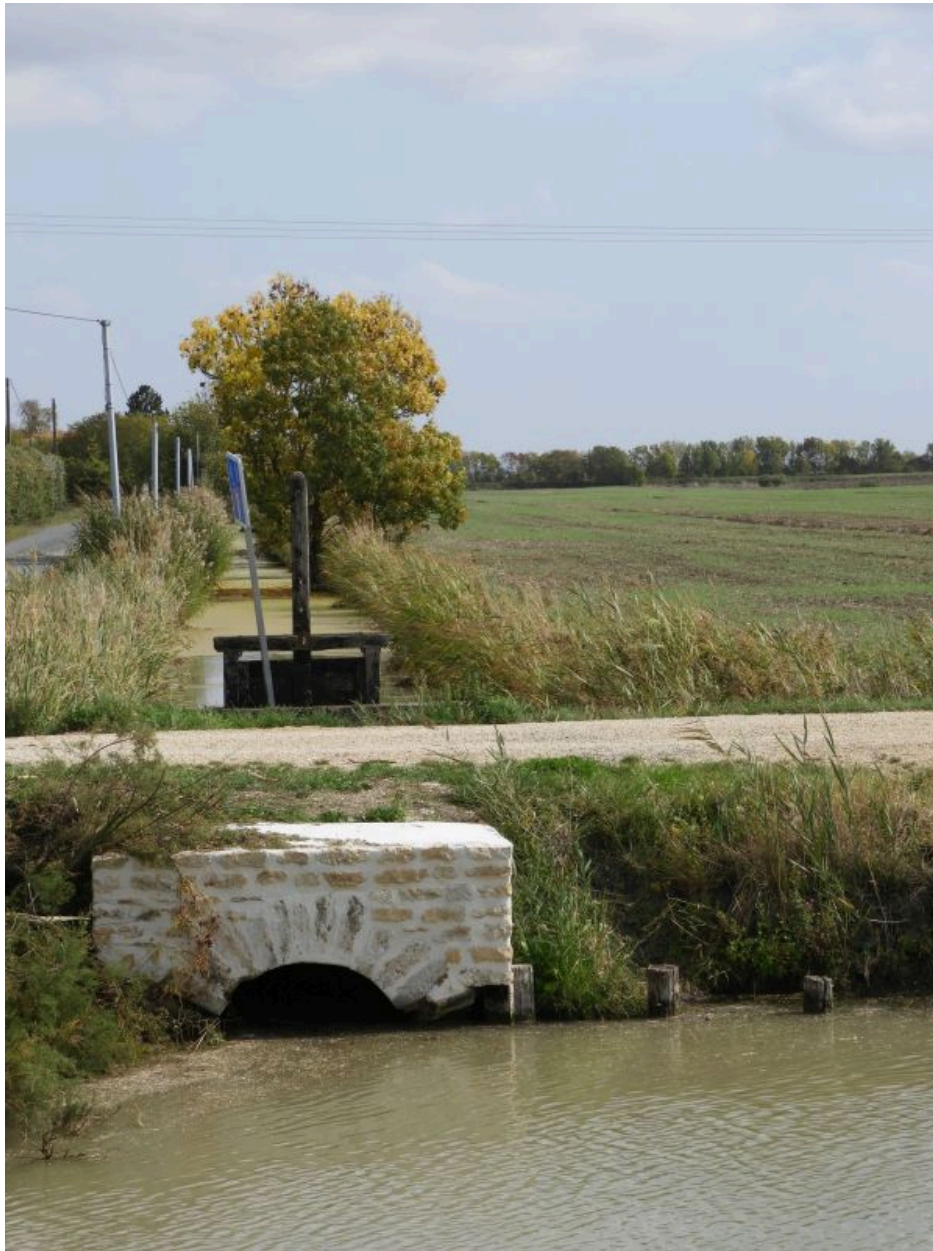
Arceau près de la cabane de Saint-Ignace, à Sainte-Radégonde-des-Noyers, avec portique et crémaillère en bois.
