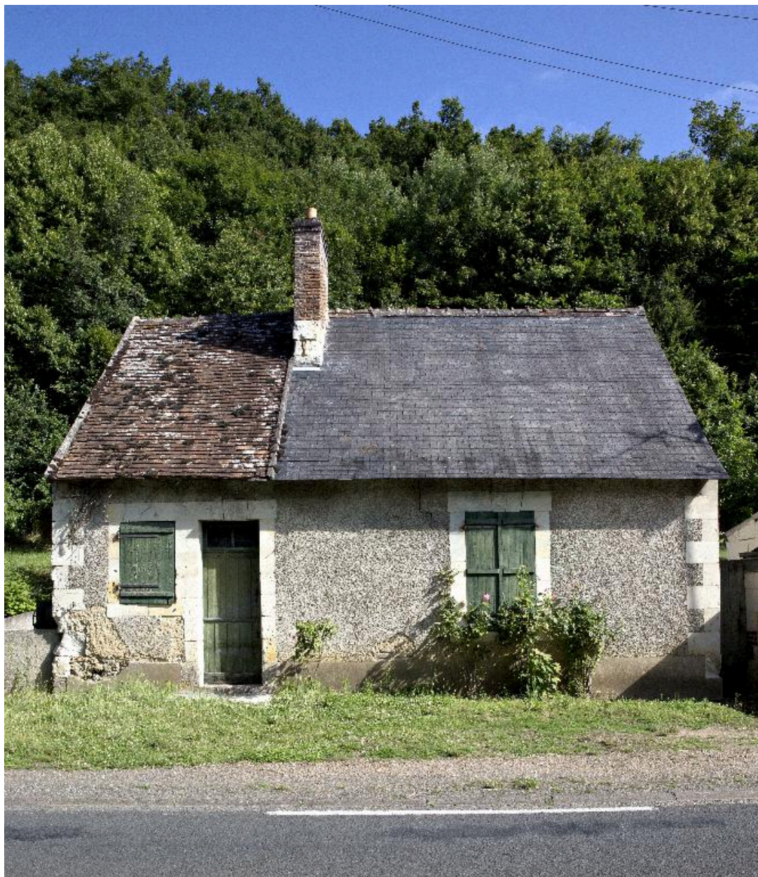
Lavenay (toiture en ardoise) et Poncé (toiture en tuile), les écluses.
