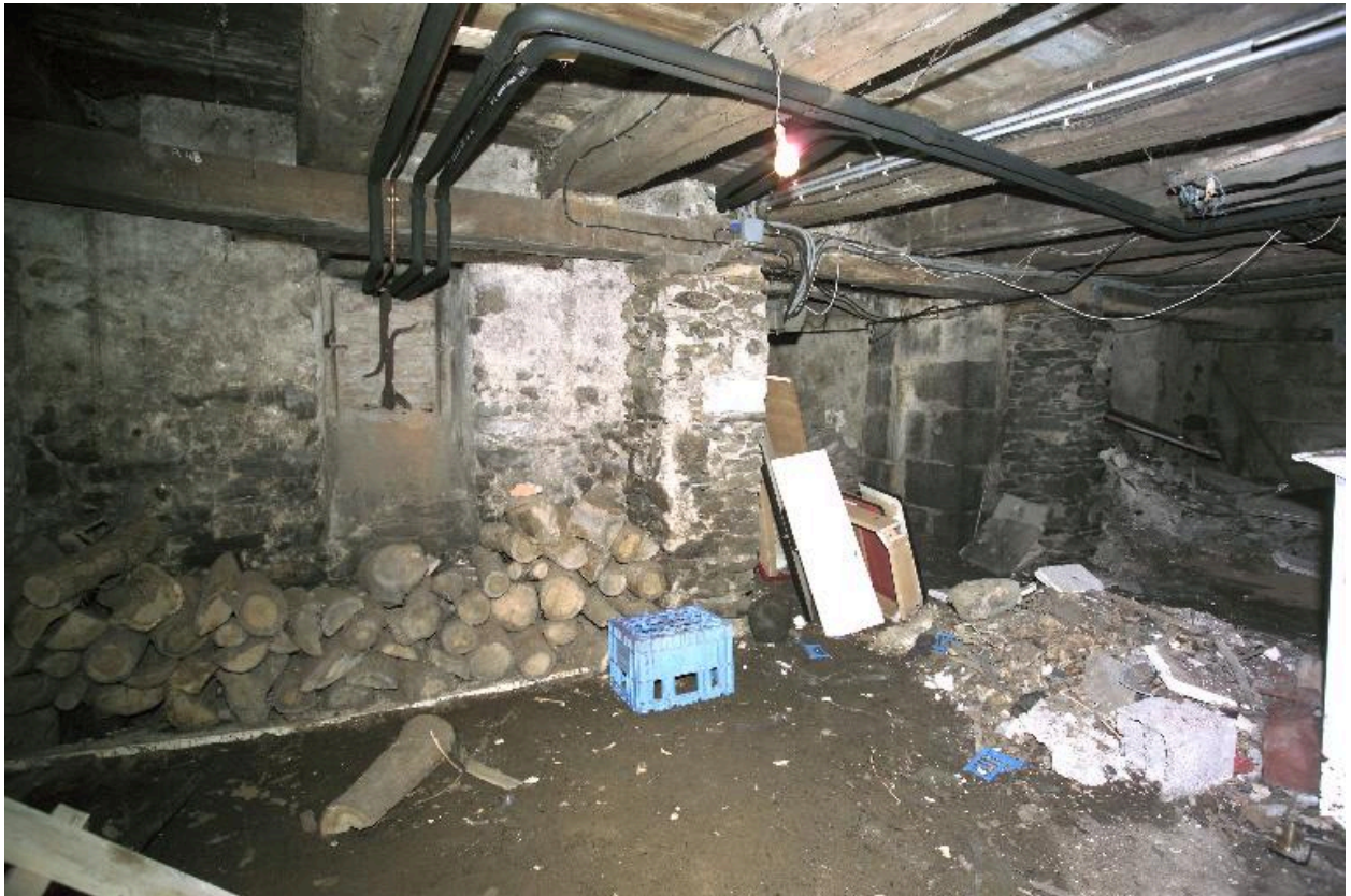
Le niveau des caves, détail d'une ouverture du côté de la Loire (à l'ouest de l'entrée).
