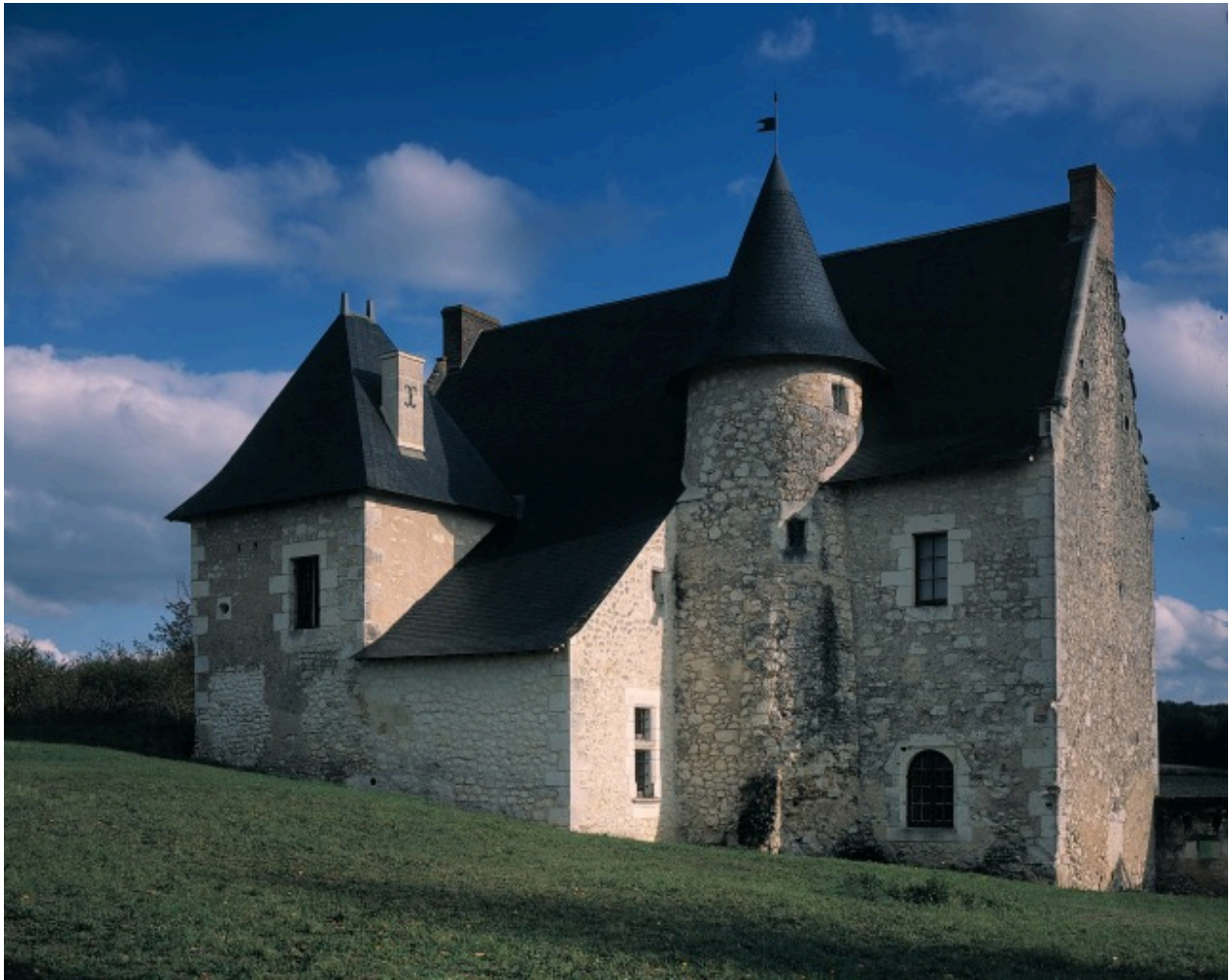
Vue de volume de la façade postérieure.
