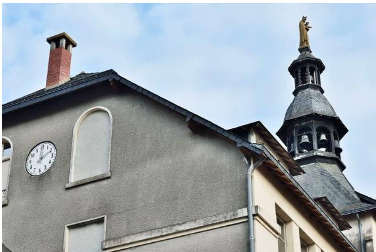
Établissement depuis l'Ouest. Campanile.
