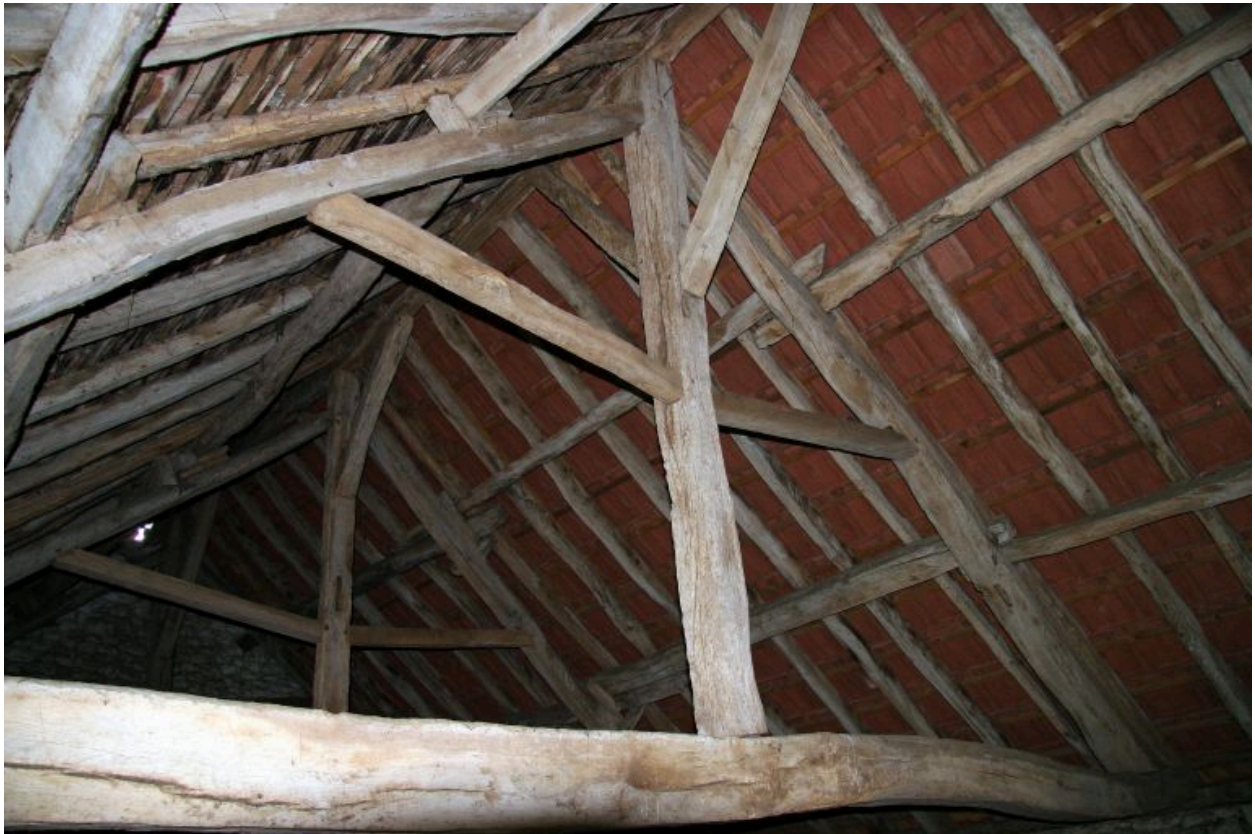
Charpente sur la maison et dépendances.
