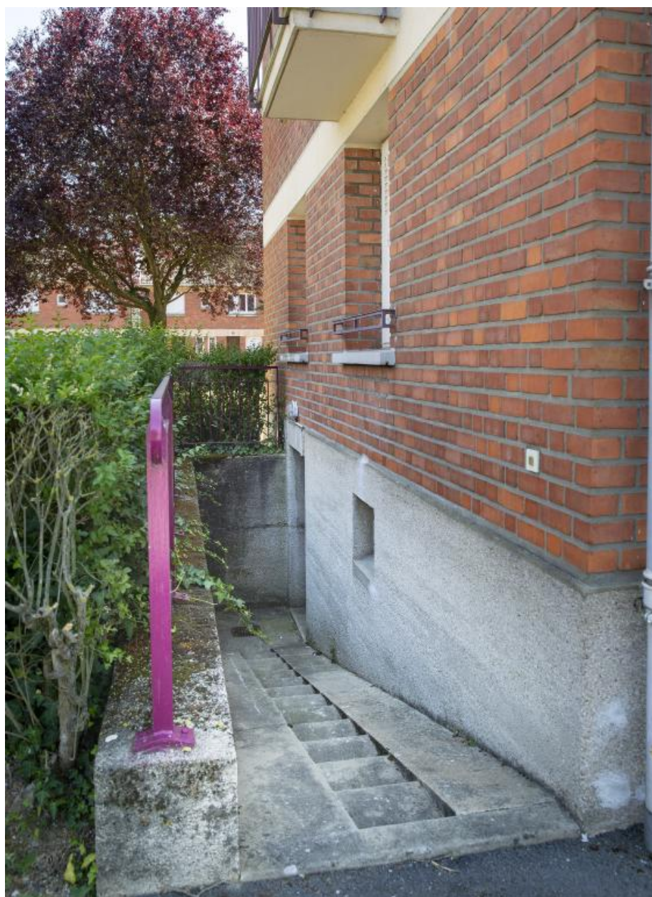
Vue de l'accès au sous-sol du bâtiment B1.
