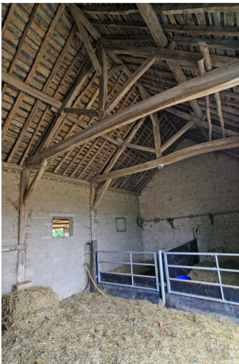
La grange méridionale : charpente à pannes.
