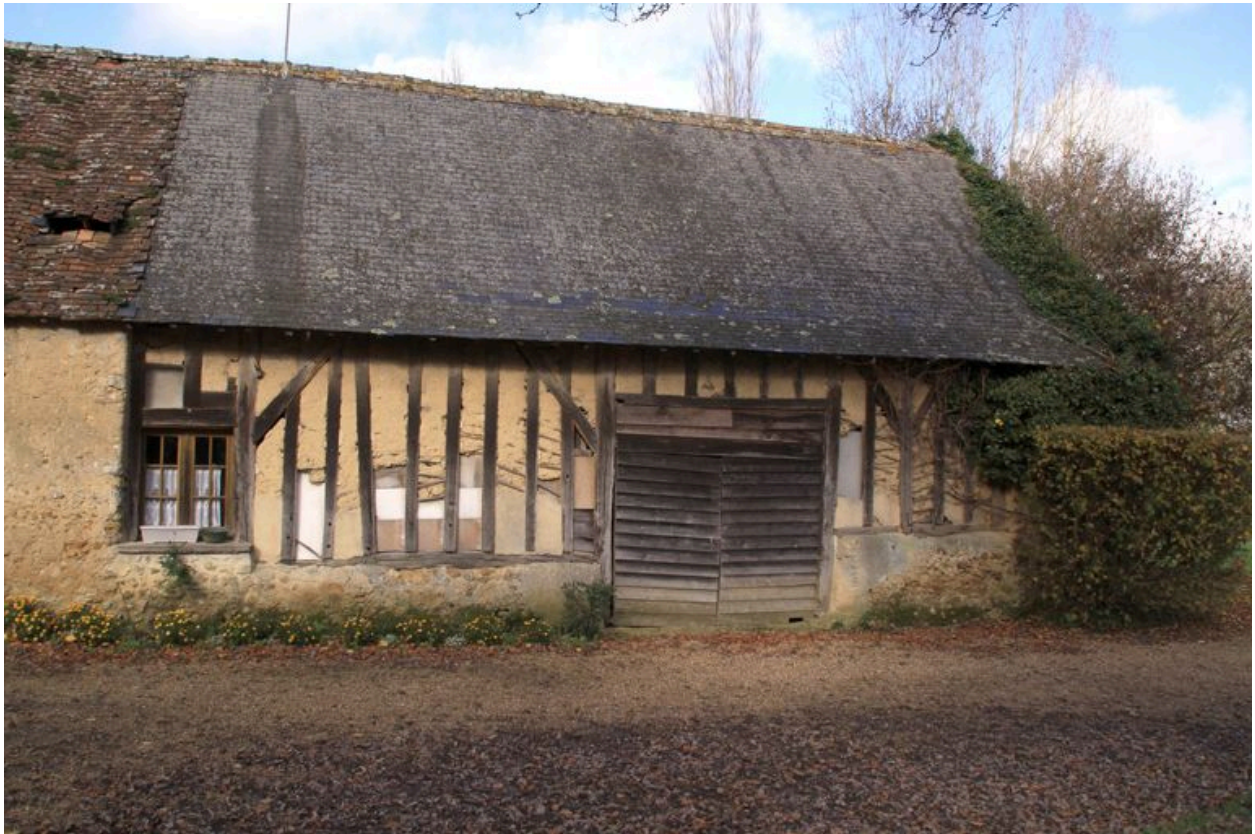
Grange en pan de bois à grille sur solin en moellon.
