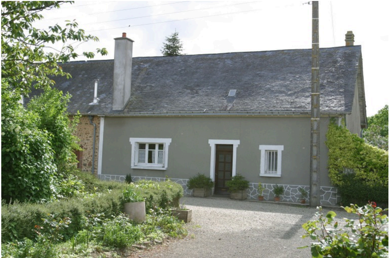
Le logis et une partie de l'étable vus depuis le chemin d'accès à l'est.
