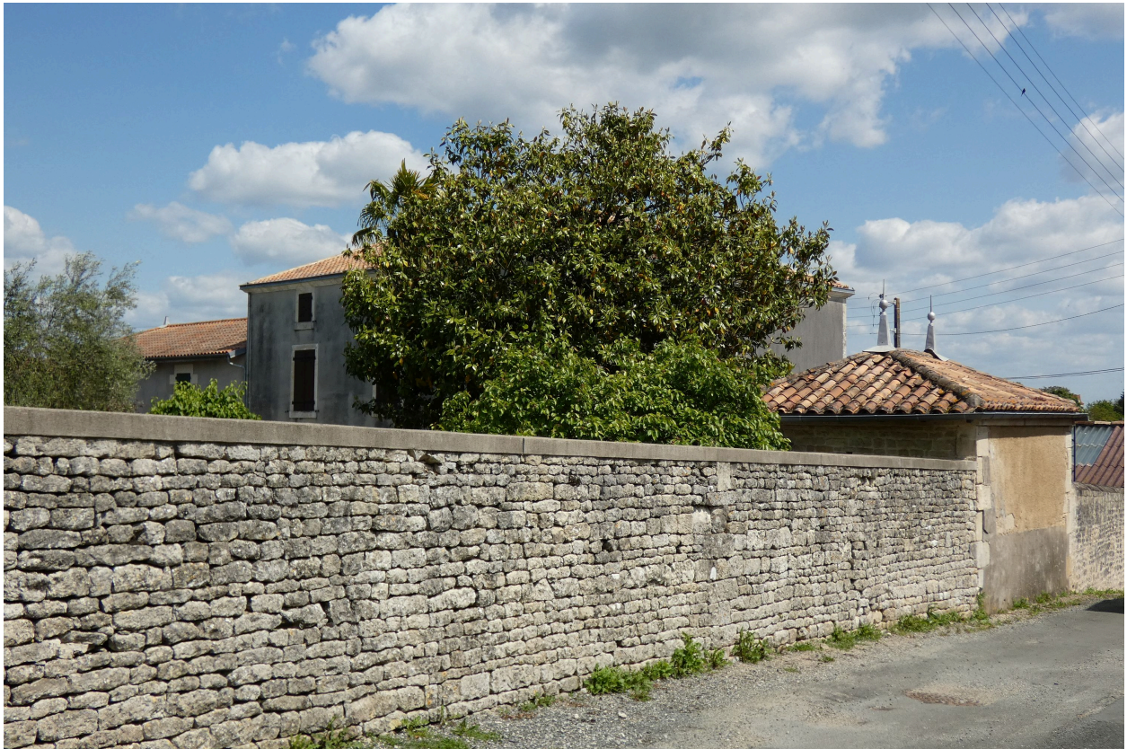
La propriété et son mur de clôture vus depuis l'ouest.
