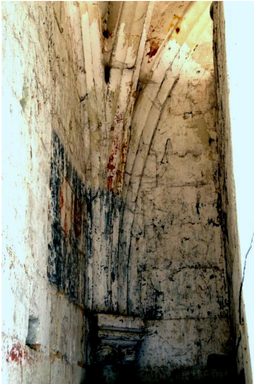
Le chœur, retombée des ogives : profil de moulures concaves.
