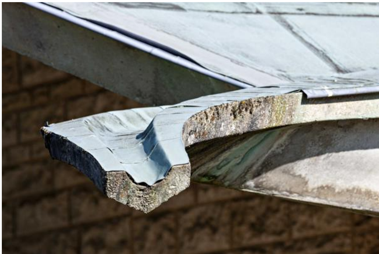
Gouttière en béton recouverte de tôle.
