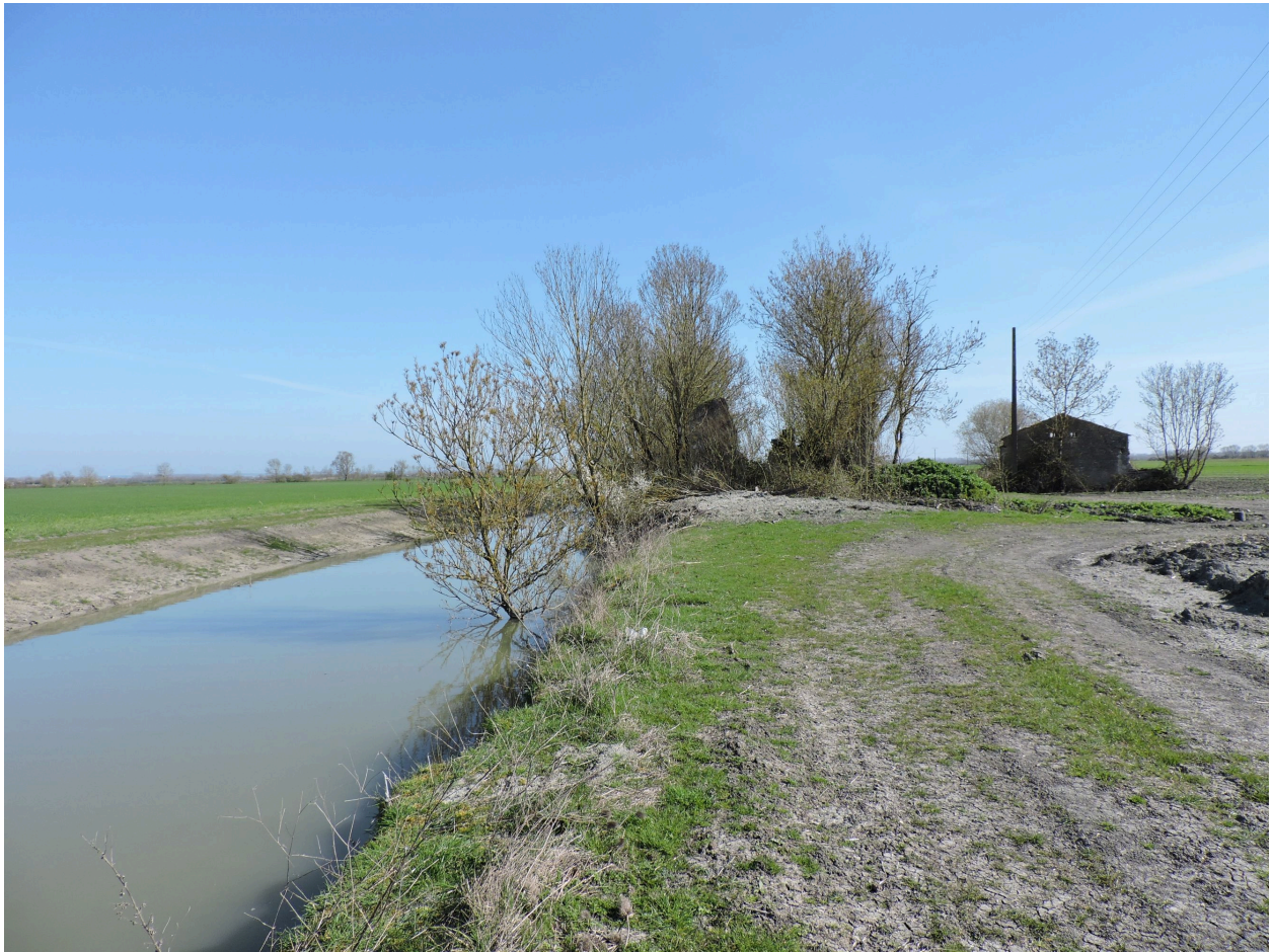
Les ruines de la cabane le long du canal du Pont Tord, vues depuis le sud-ouest.
