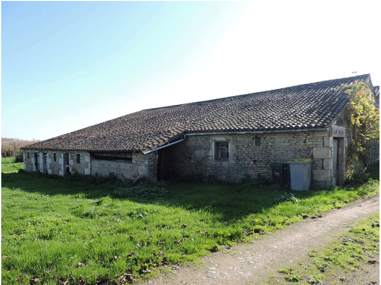
La grange-étable au nord du logis, vue depuis le nord.
