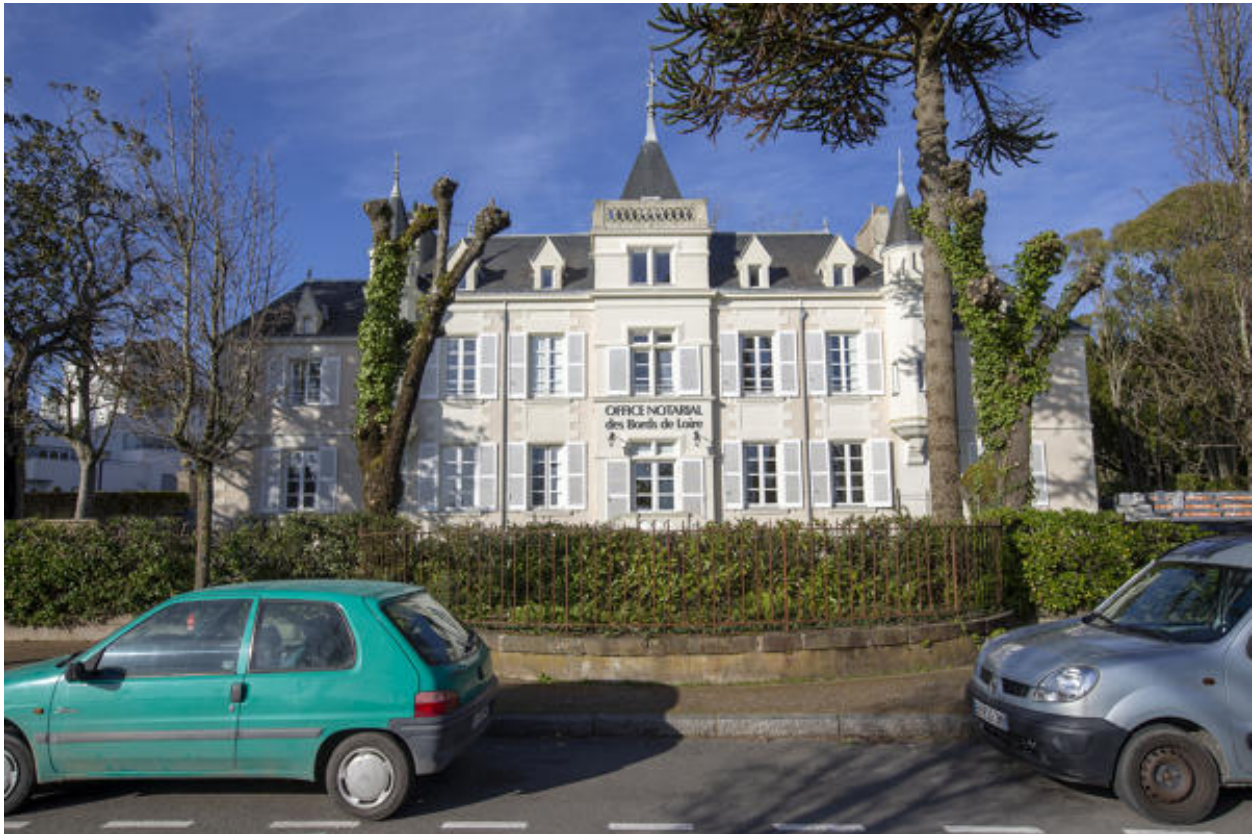
Logement patronal, 1 quai Jean-Pierre Fougerat.
