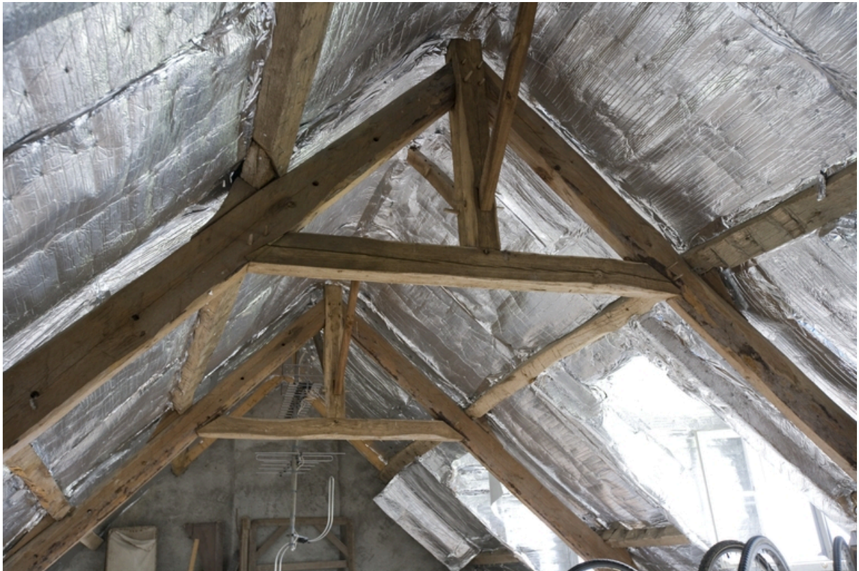
Logis. Combles. Charpente.
