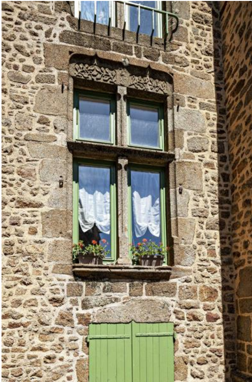
Ancien hôtel particulier, 31-33 rue Dorée. Détail de la fenêtre du rez-de-chaussée, accolades et lierres.
