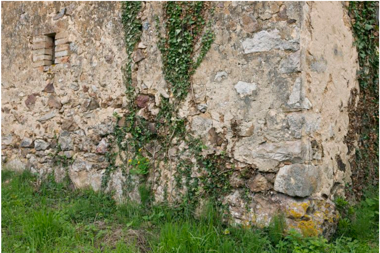
Gros-oeuvre de la grange au droit du logis de la ferme 2.
