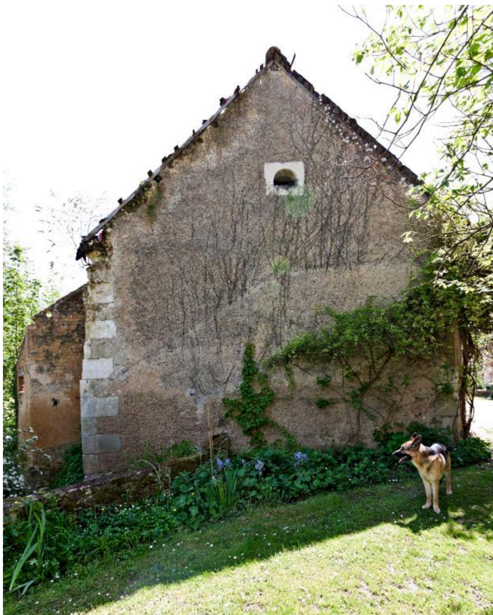
Mur-pignon nord de la grange-étable
