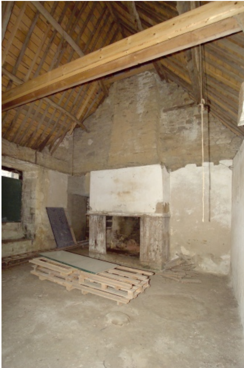
Bâtiment sud, intérieur.
