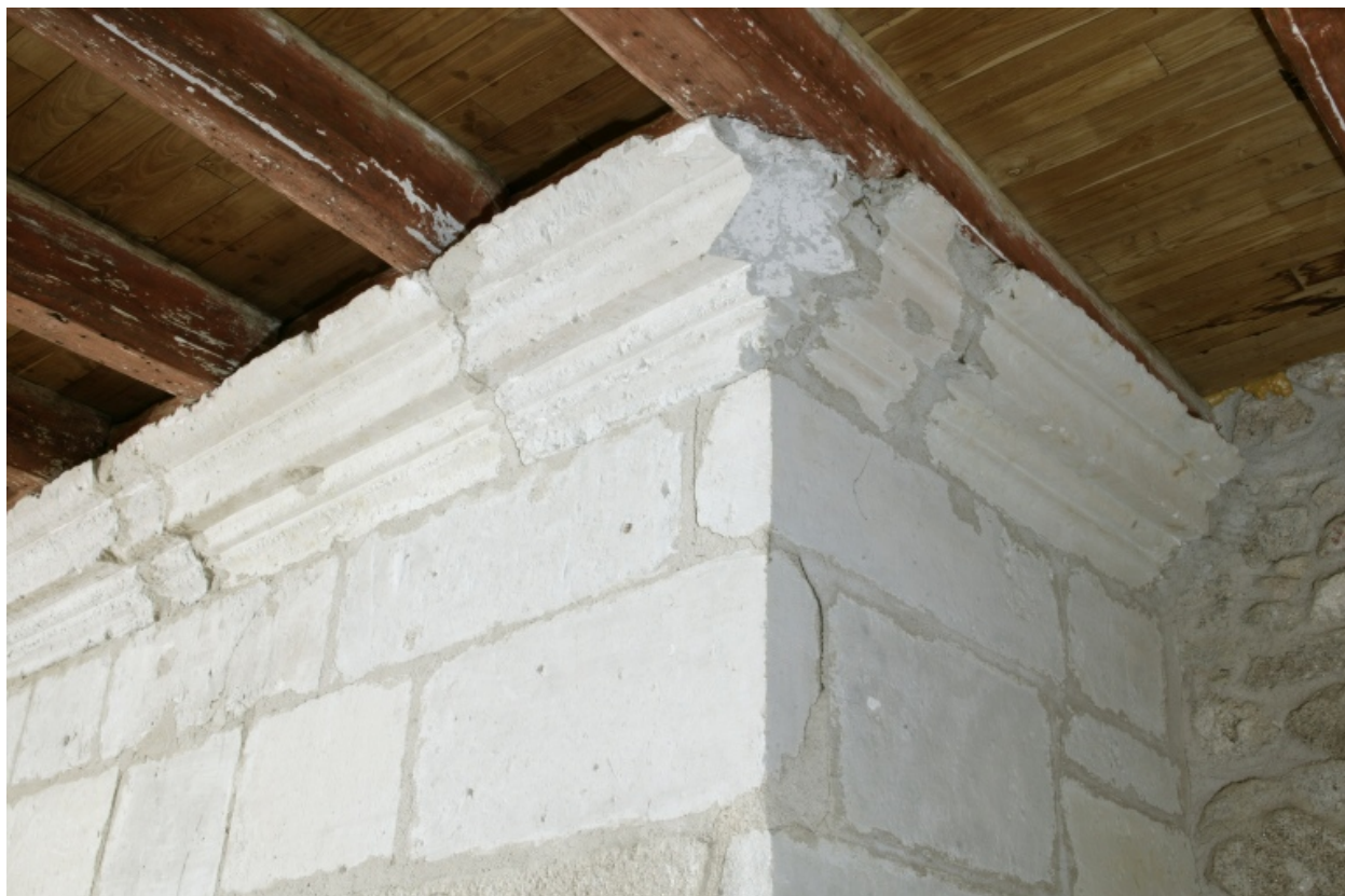
Cheminée sud au premier étage, détail de la hotte.
