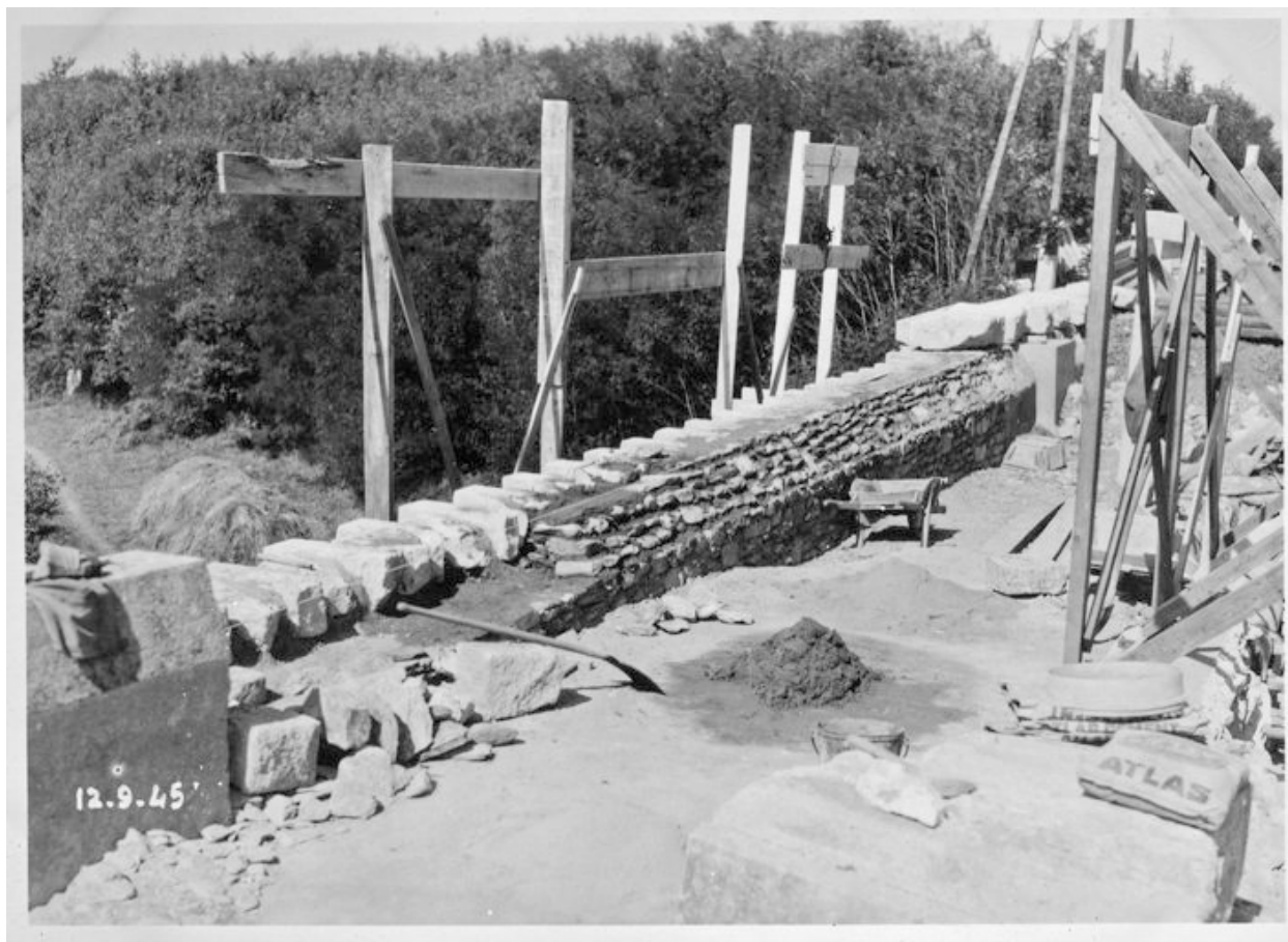
Remblaiement des arches, 12 septembre 1945.
