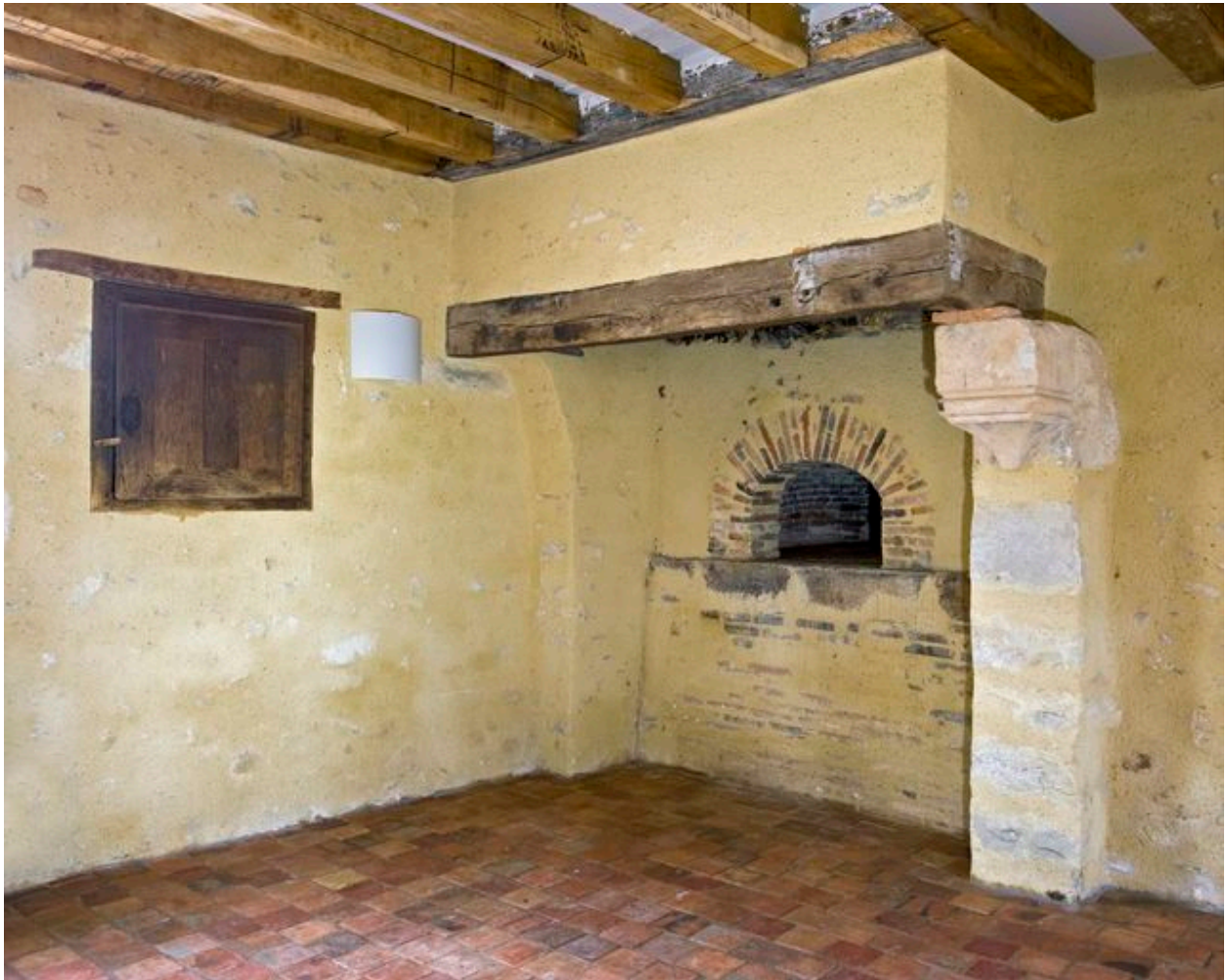
Cheminée du fournil
