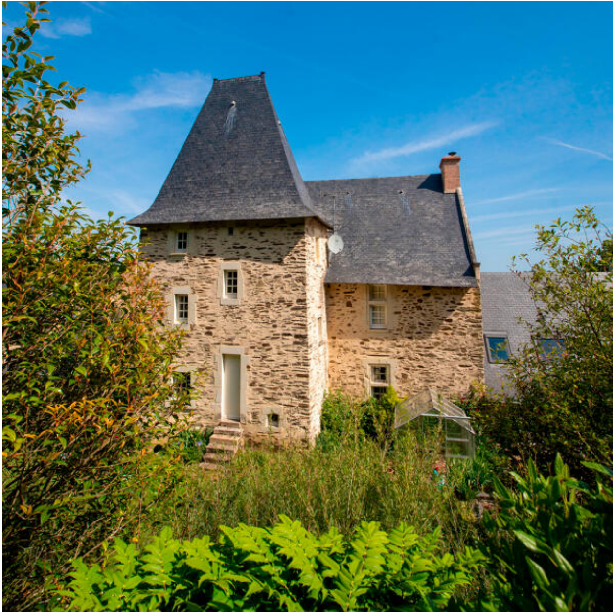
L'élévation postérieure et le pavillon de l'escalier.
