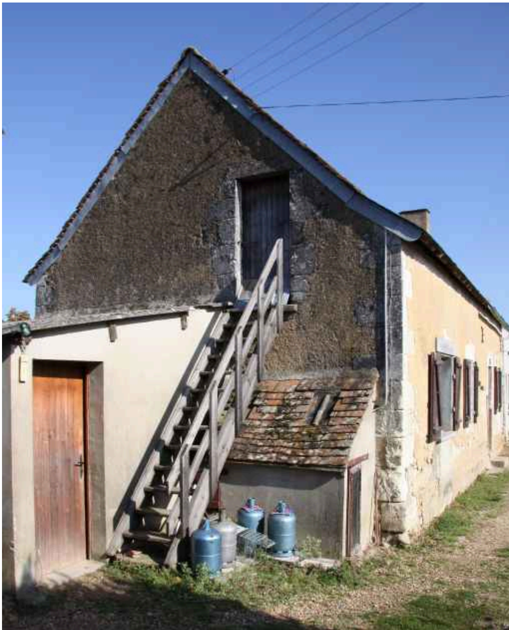
La maison n° 2 : pignon.
