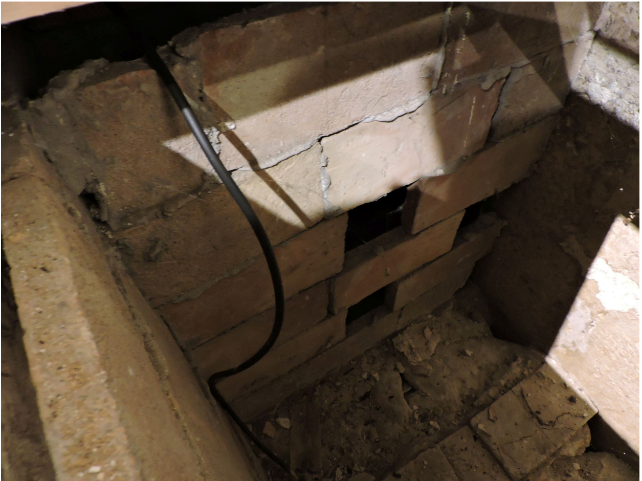
Ensemble nord : structure interne de l'autel, en brique.
