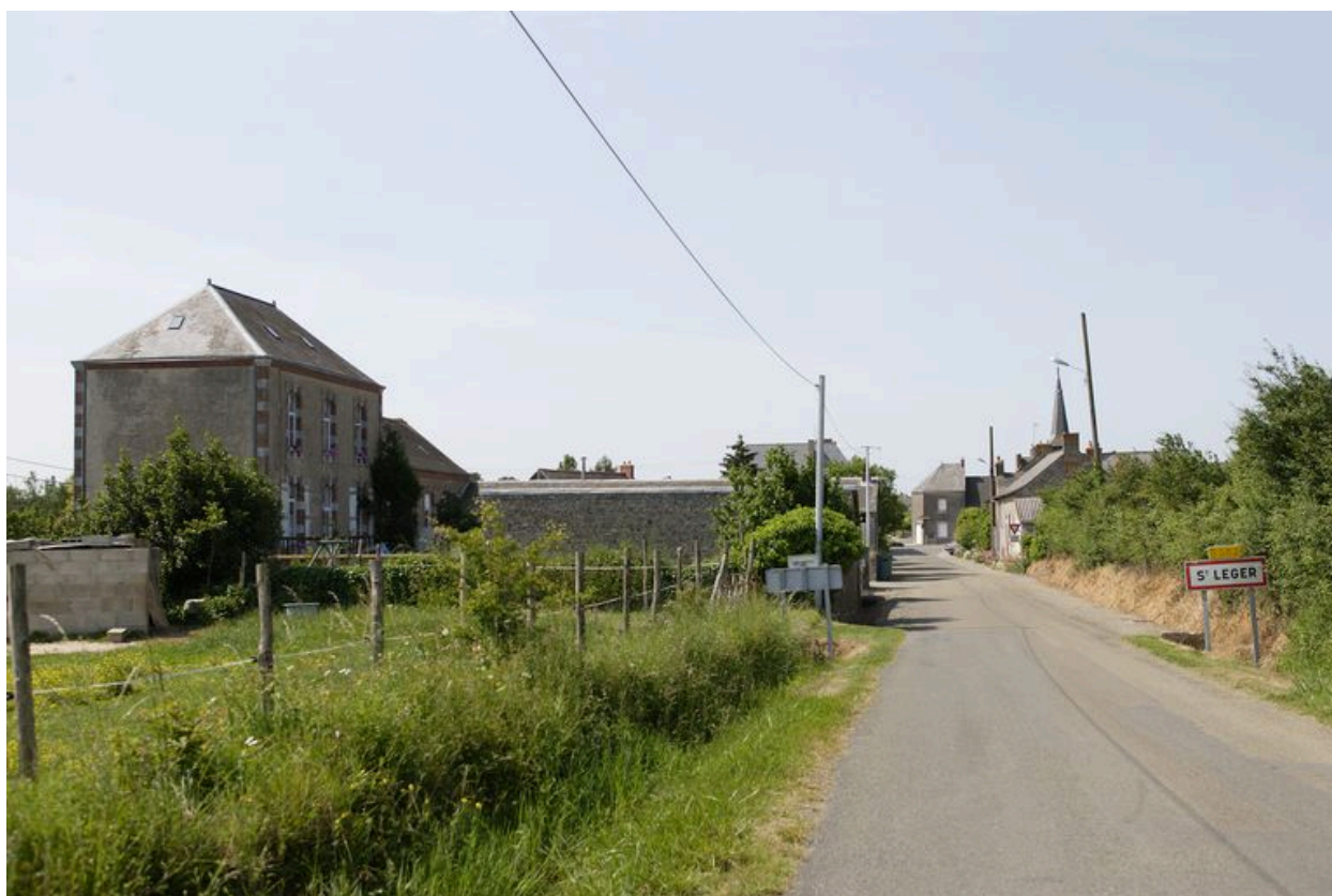
Vue d'ensemble depuis l'entrée du bourg route de Saint-Jean.
