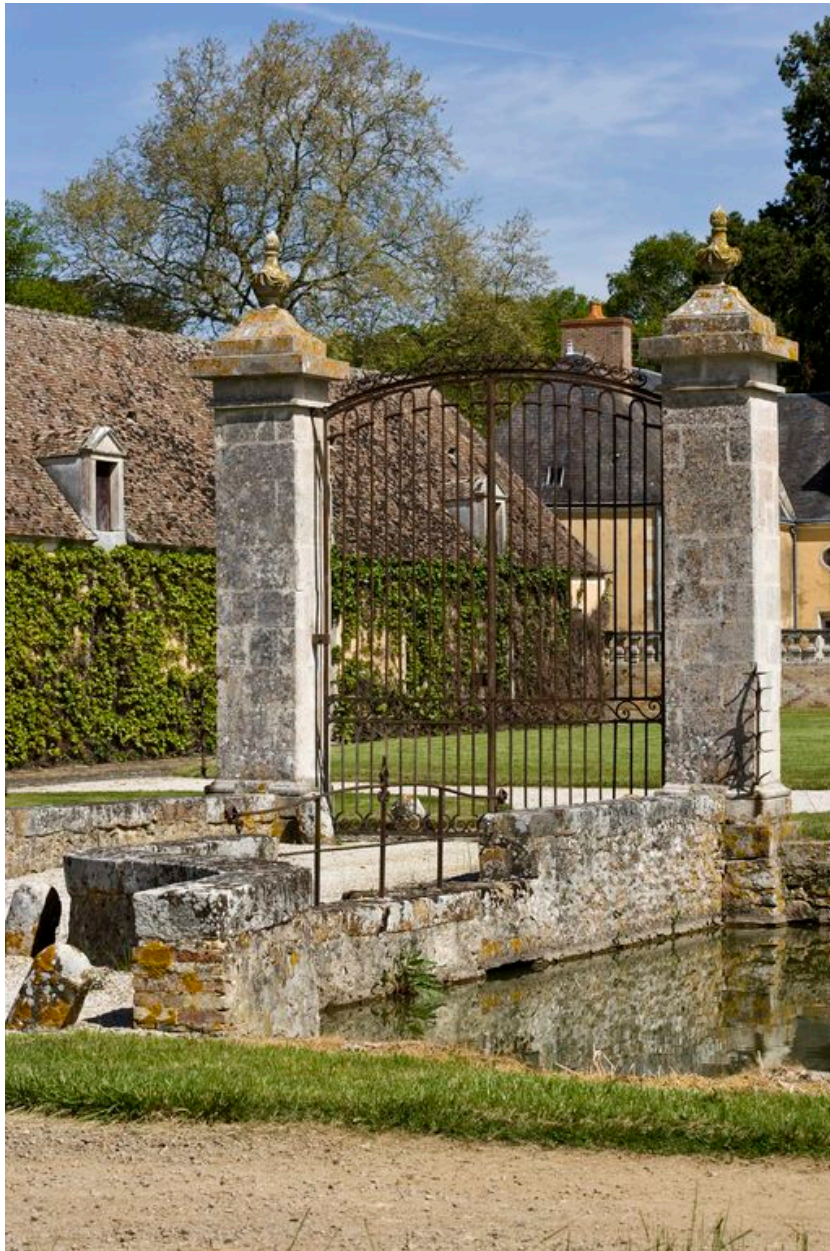
Pont et portail d'entrée de la basse-cour.
