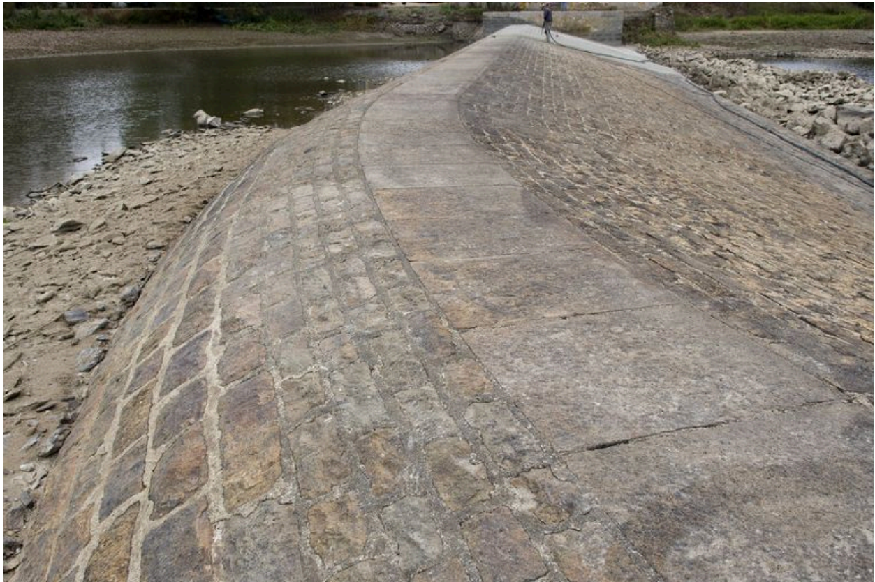
Vue partielle du barrage vers la rive gauche, pendant les écourues de 2009.
