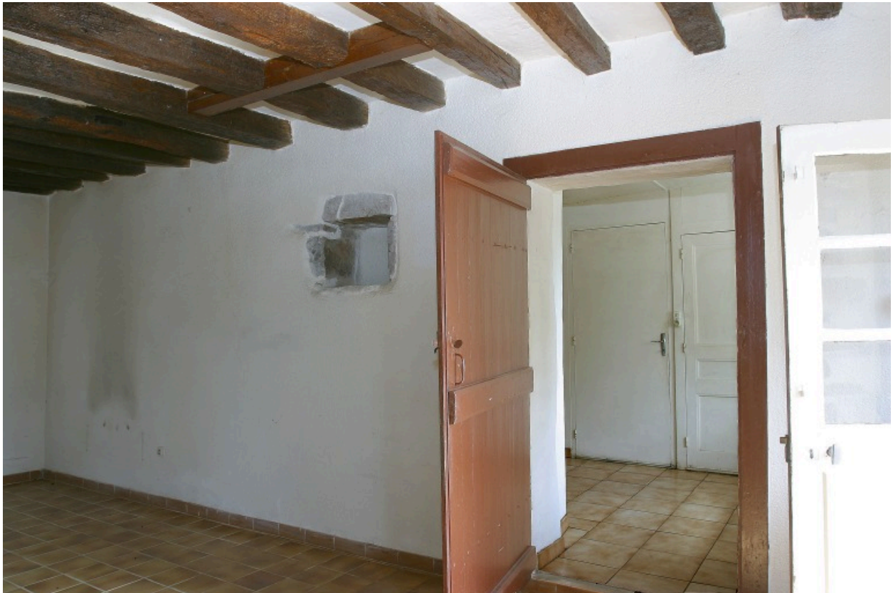
Etage de soubassement. Pièce 3A : mur nord.
