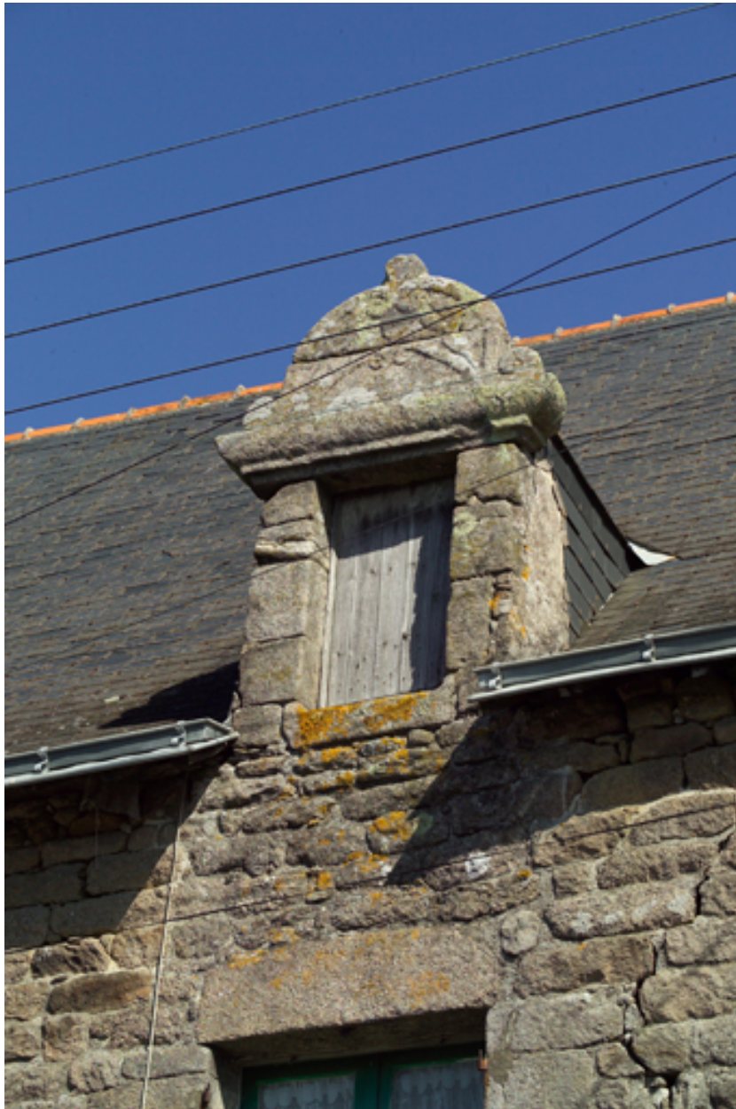
Détail de la lucarne est.
