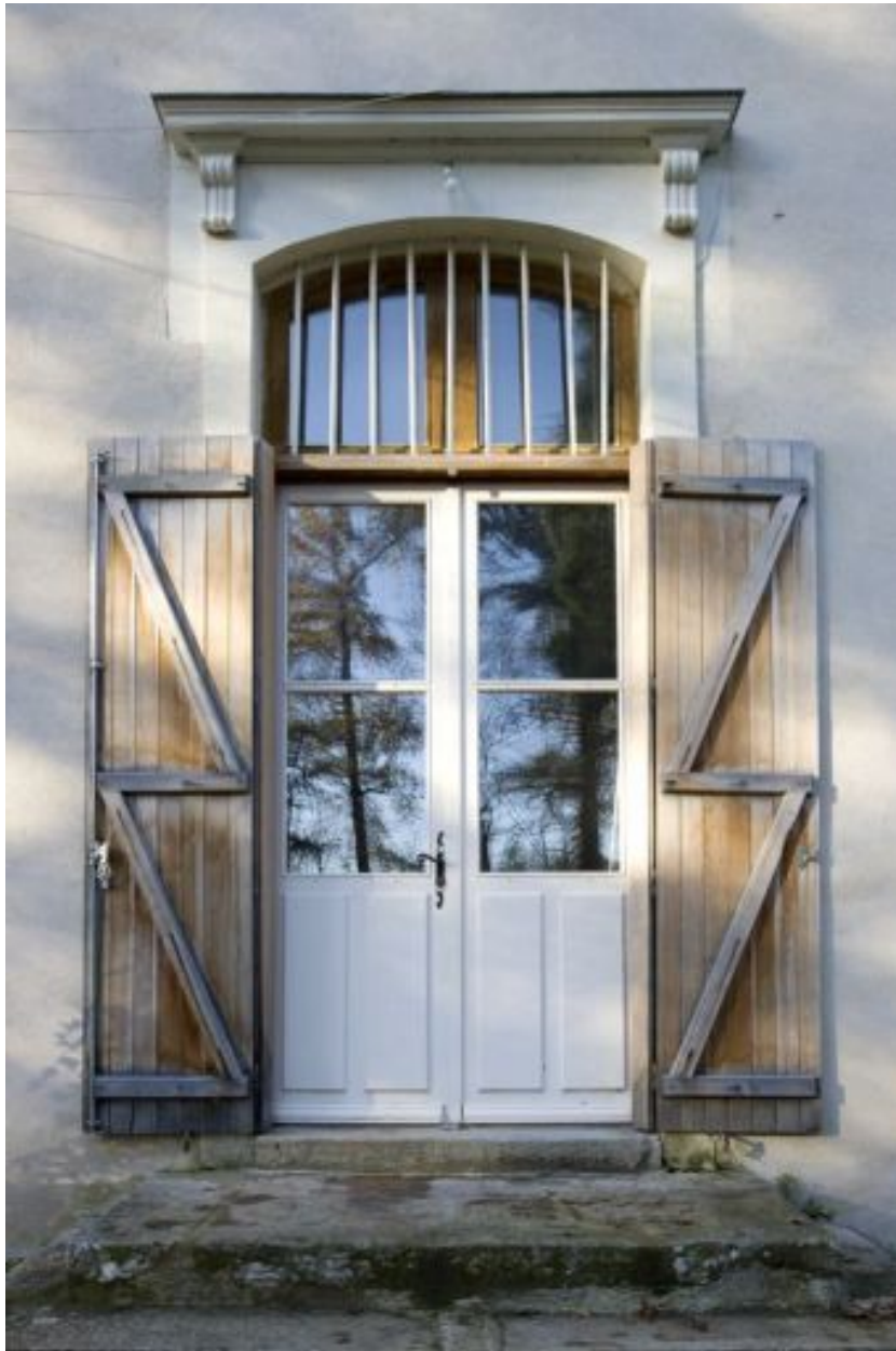
La demeure : façade sud, la porte d'entrée.
