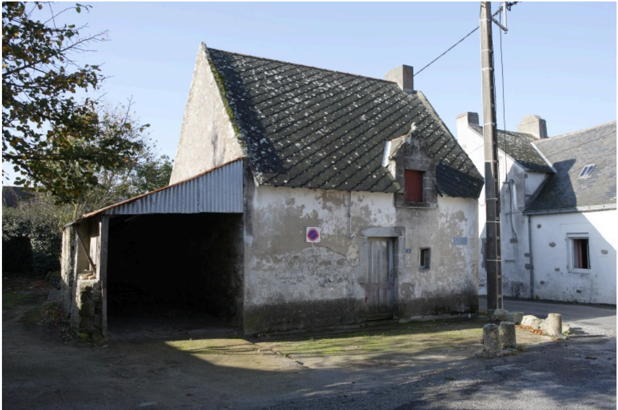
Vue du logis depuis l'est.
