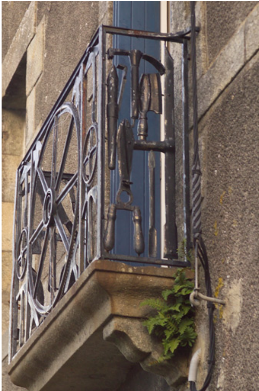
Garde-corps du premier étage, face est.
