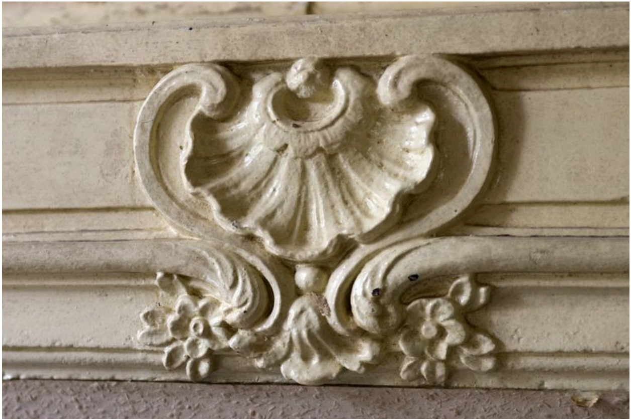
Logis, cheminée de la salle à manger, détail.
