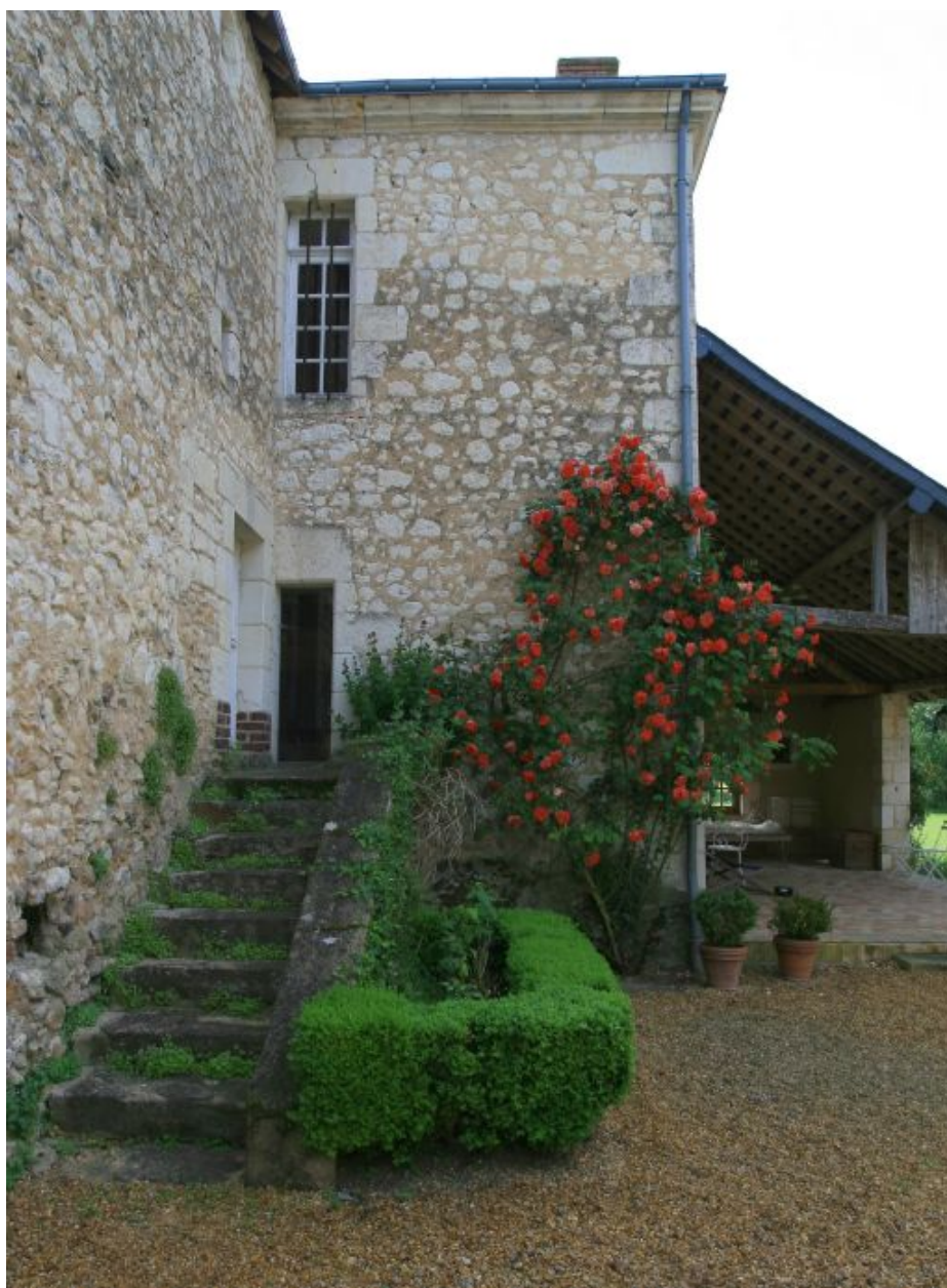
Extrémité sud de la façade sur cour.
