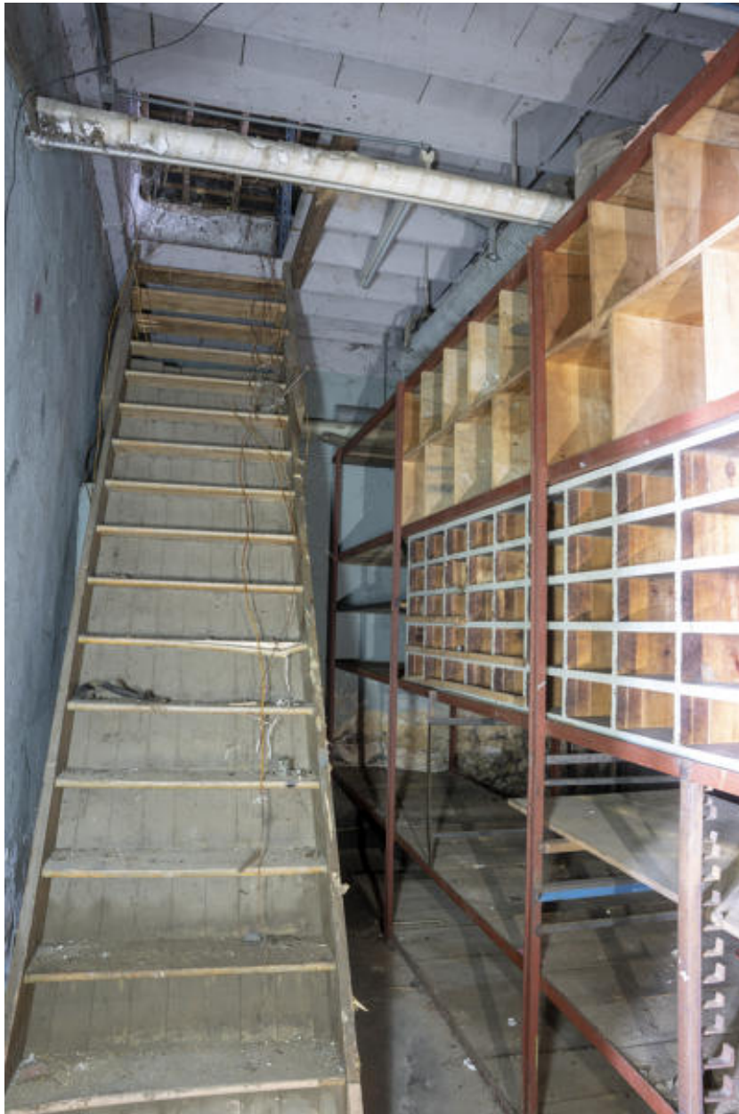
Escalier d'accès à l'étage de l'atelier E.
