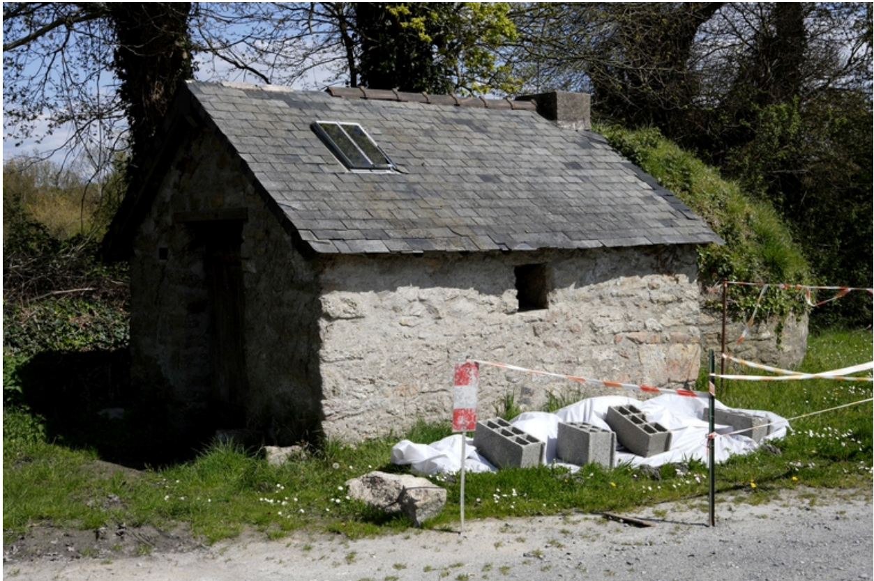
Fournil (rue du Pont).
