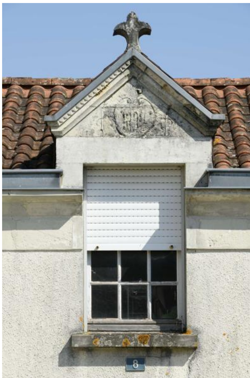
Beausse, 8 rue de la Mairie. Maison, détail de la lucarne datée 1892.
