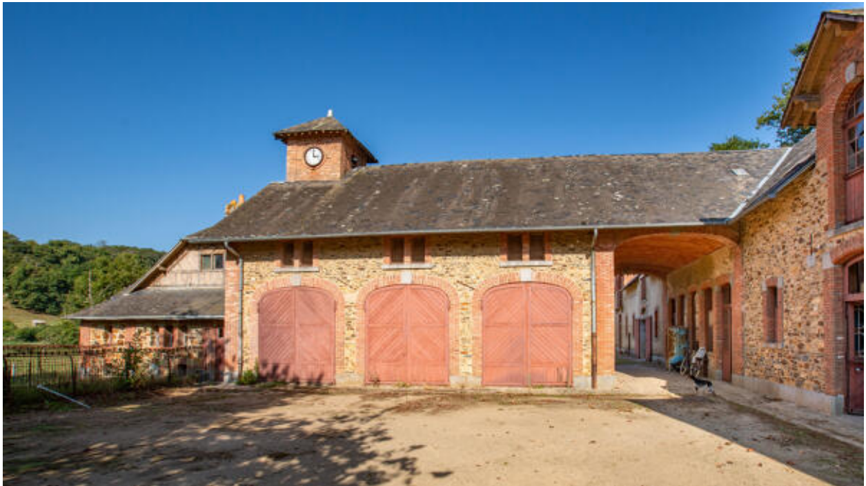
Les remises et le passage couvert.
