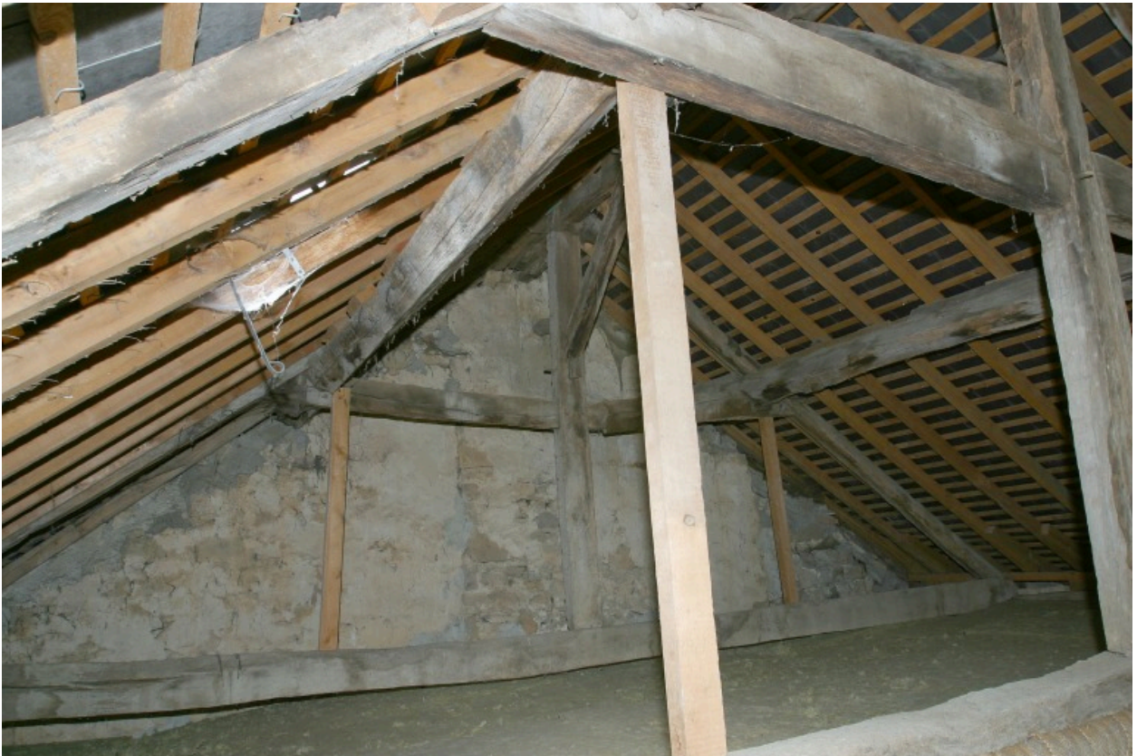
La charpente du logis accolé nord.
