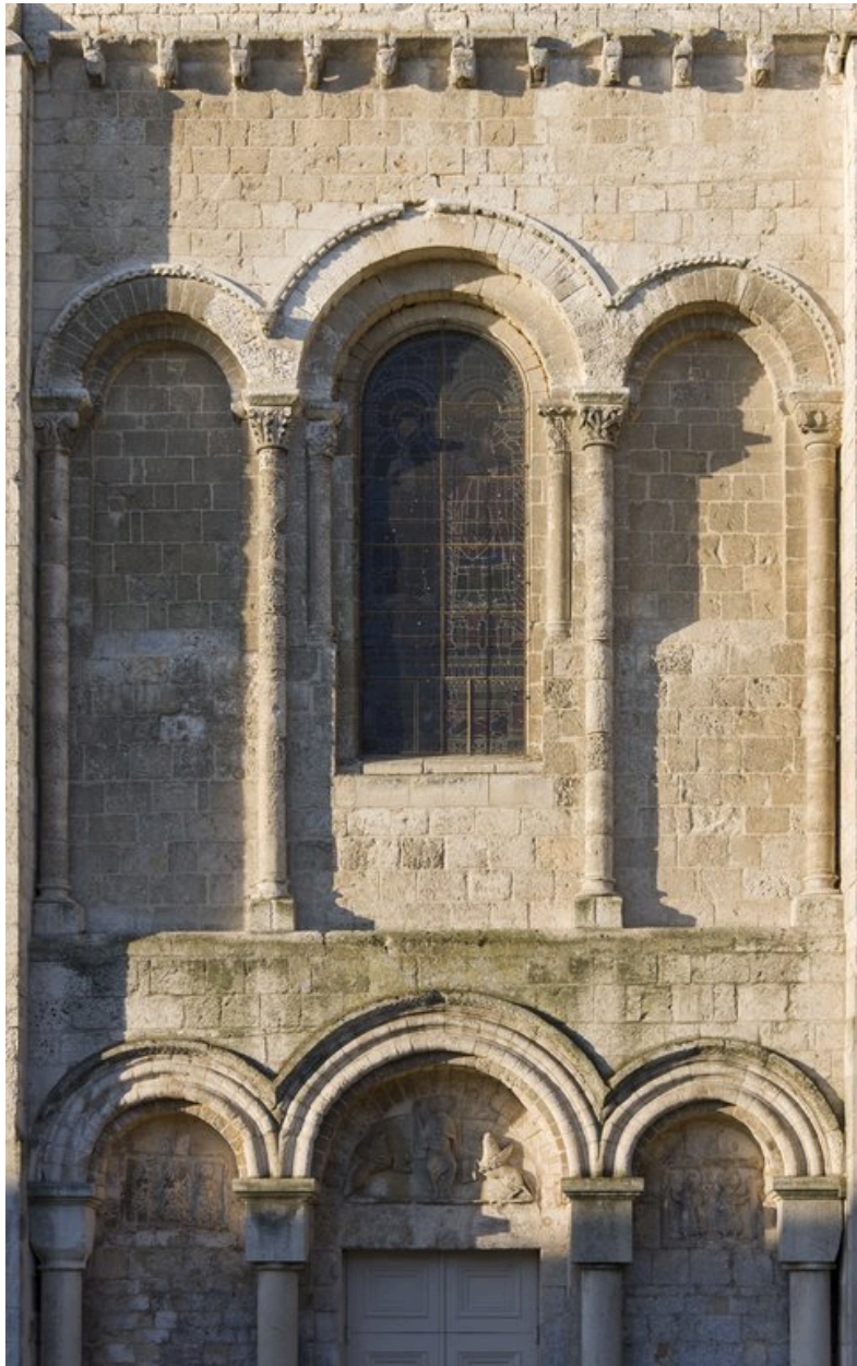
Façade du bras nord du transept : niveau supérieur.
