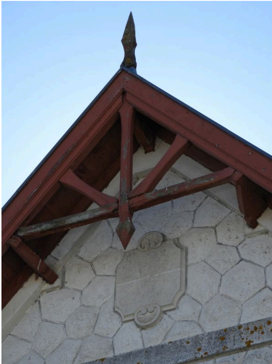
Détail de la façade : ferme de charpente apparente et cartouche.
