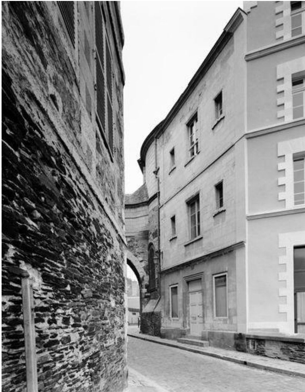
Façade bâtie au milieu du XIXe siècle entre le chevet de l'église (à gauche sur l'image) et le bâtiment de 1702 (à droite) : vue d'ensemble depuis la place Saint-Eloi.
