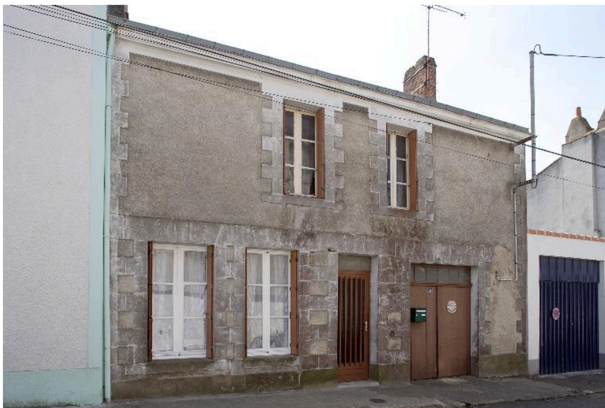
Maison n° 31 rue du Faisan.
