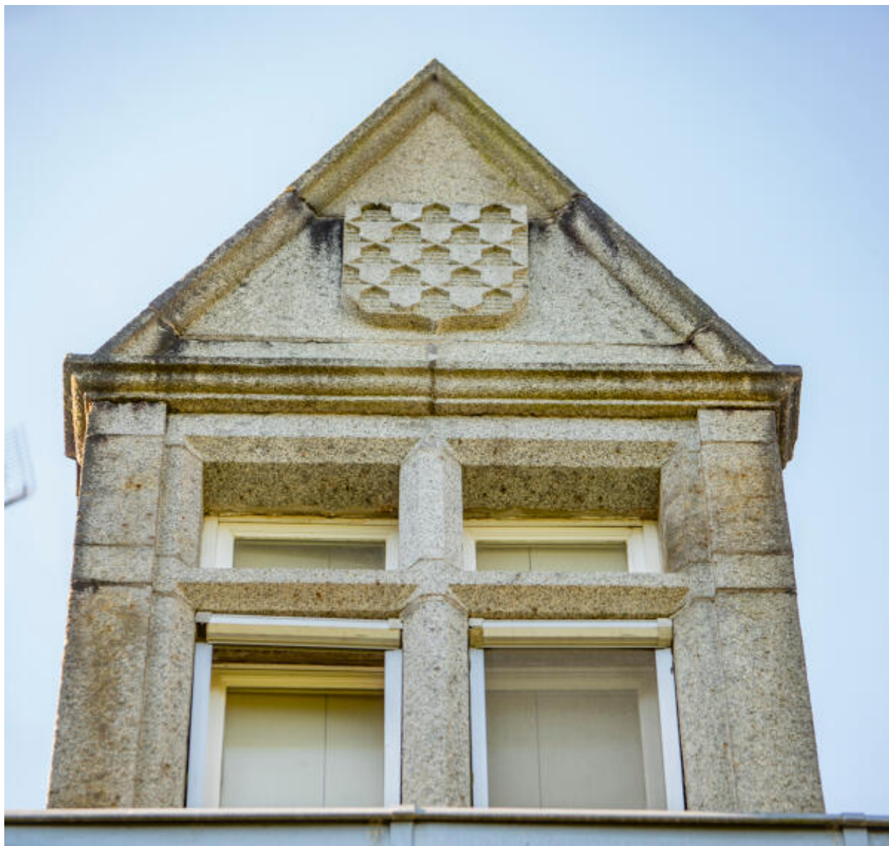
La lucarne centrale armoriée.
